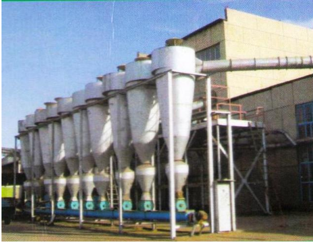
Şəkil 4. Pambıq zavodundan bir görünüş
